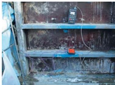
Рисунок 4. Фрагмент опалубки стены и способ размещения датчиков температуры
